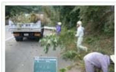
伐採による道路の保全
