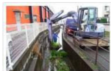
側溝清掃による水路の保全
